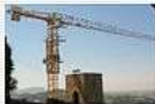
Gru a torre
