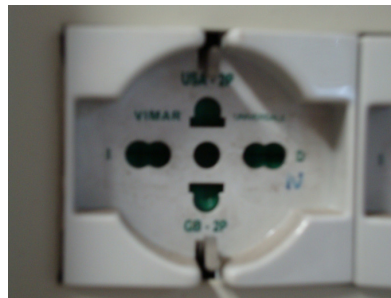
presa schuko universale con standard euroamericano
