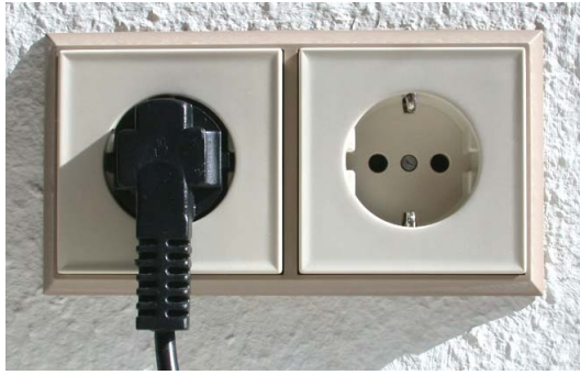
presa schuko con contatti di terra laterali
