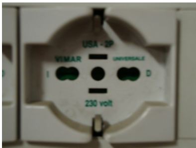
presa schuko universale con standard americano
