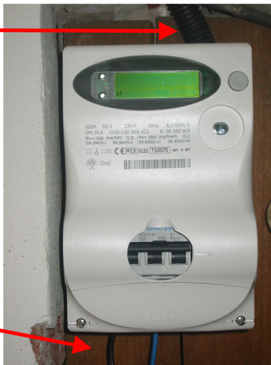
esempio di contatore installato in unità abitativa
