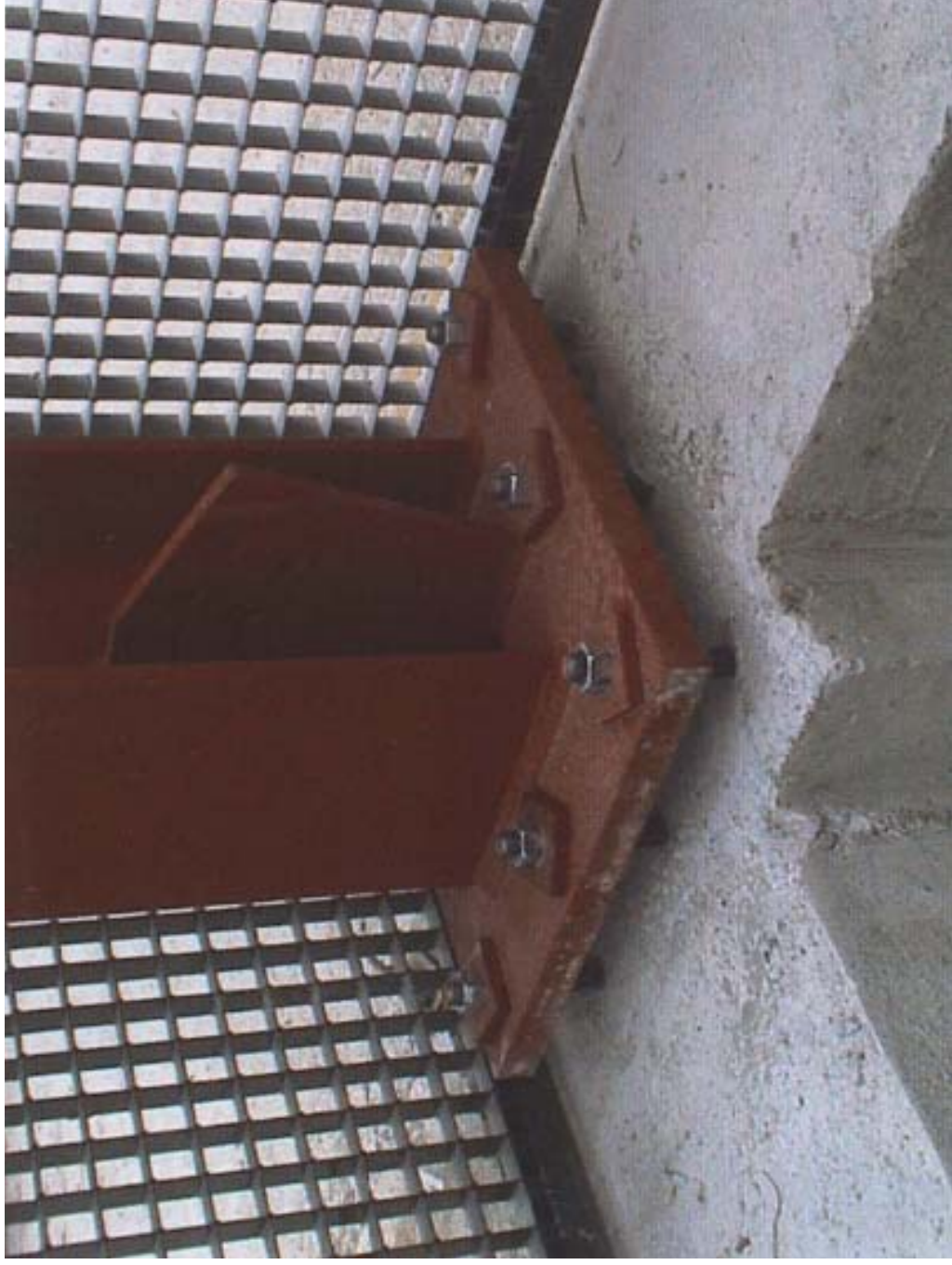
dettaglio della stoffa per i controventamenti
