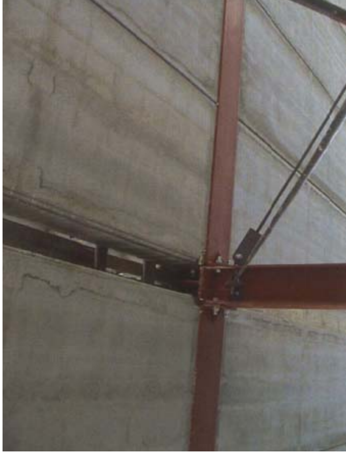
Cavedio tra lastre di solaio a predalles
