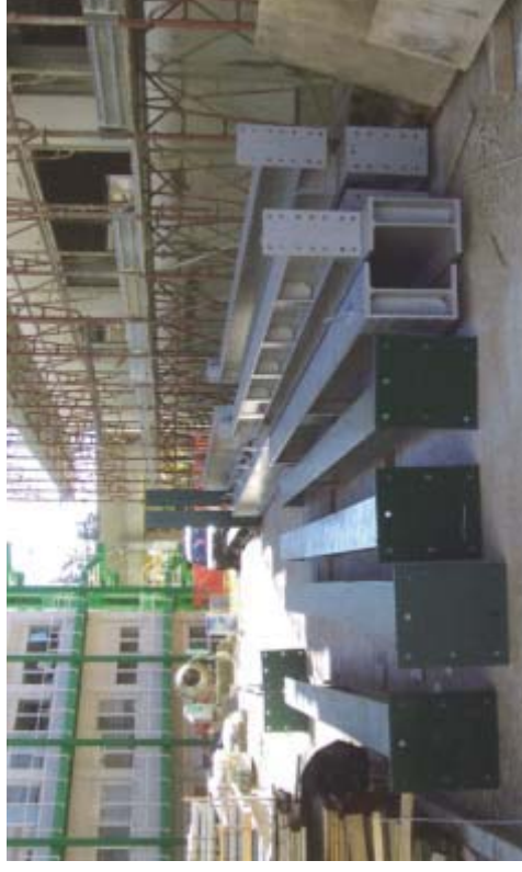
stoccaggio a piè d'opera di pilastri e travi in acciaio preforate
