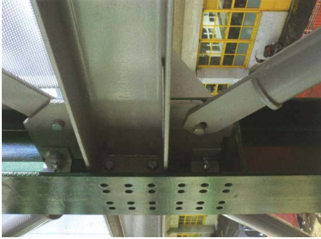
dettaglio del nodo di irrigidimento
