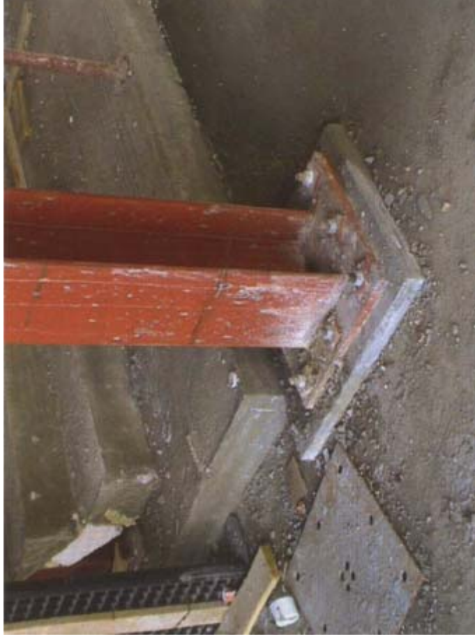
Getto integrativo del pilastro prima e dopo la scasseratura del getto
