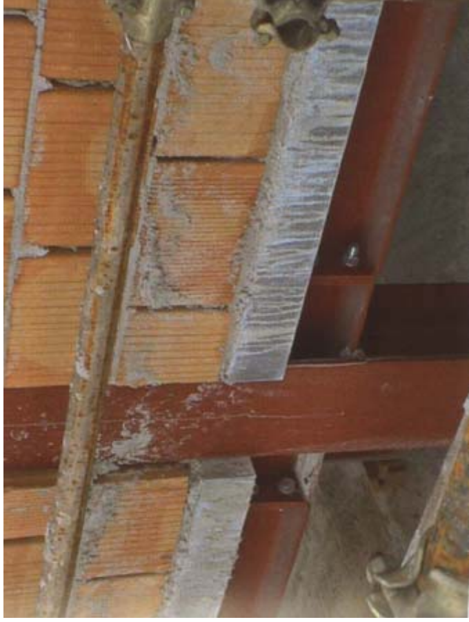
Cordolo in cis su trave in acciaio per la posa delle tamponature in blocchi di laterizio
