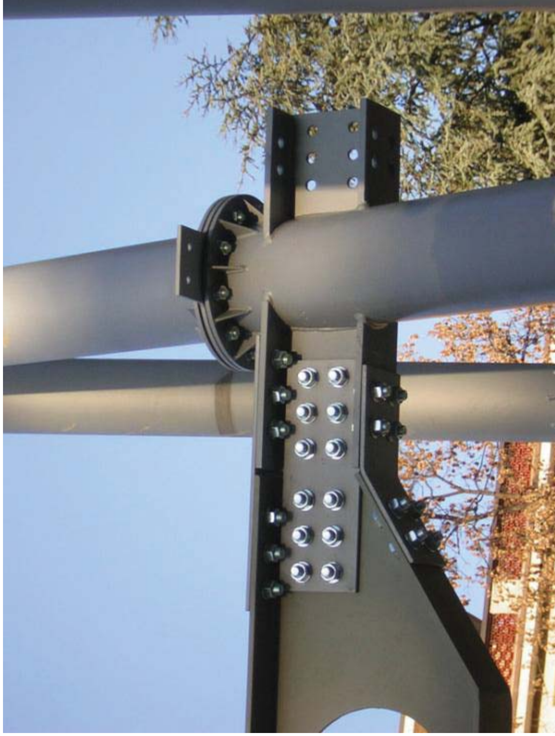
dettaglio della bullonatura fra travi e pilastri in acciaio
