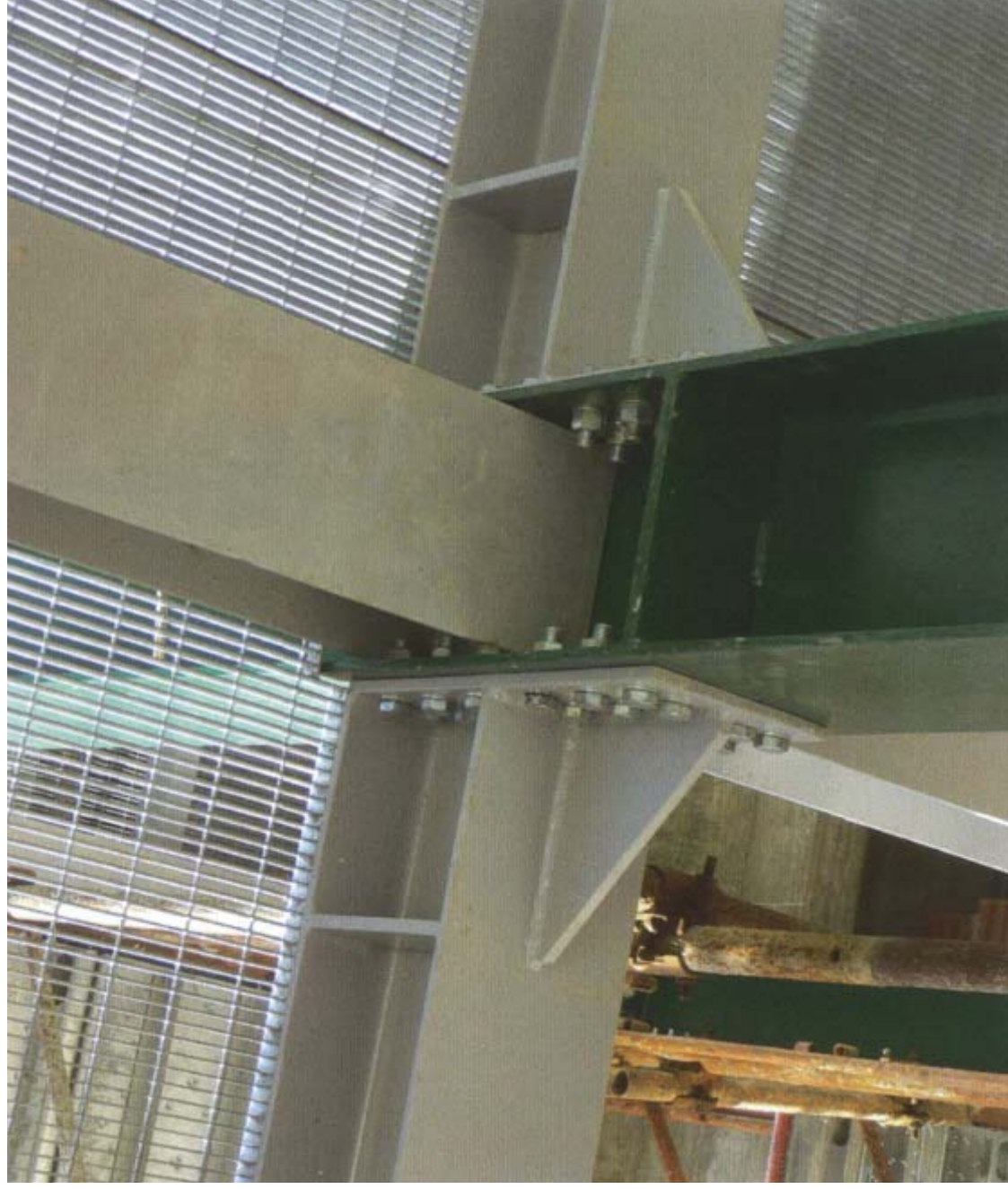
dettaglio della bullonatura fra travi e pilastri in acciaio
