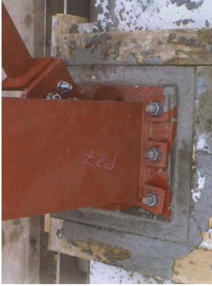
Getto integrativo del pilastro prima e dopo la scasseratura del getto
