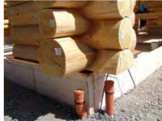
Raccordo con le fondamenta
