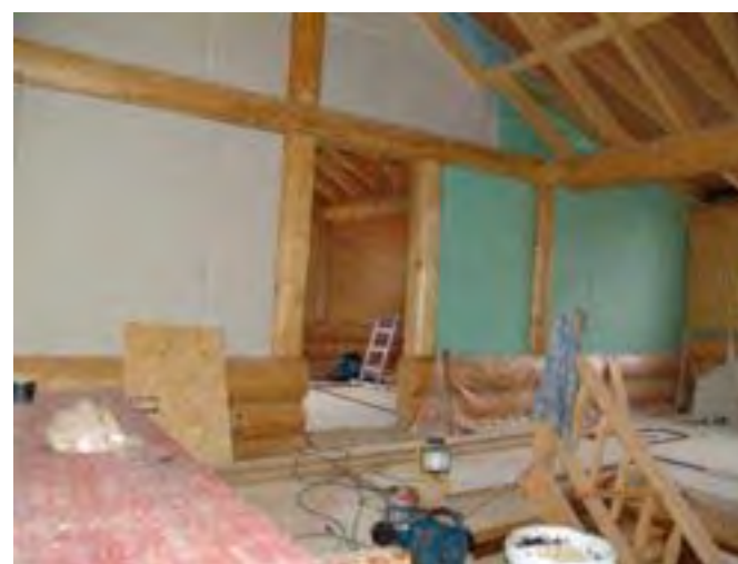
Riempimento delle Tramezze
