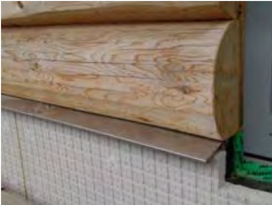
Raccordo con il Piano Seminterrato
